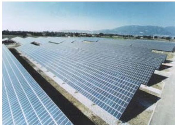
Vue d'une installation de panneaux photovoltaïques au Sahara
